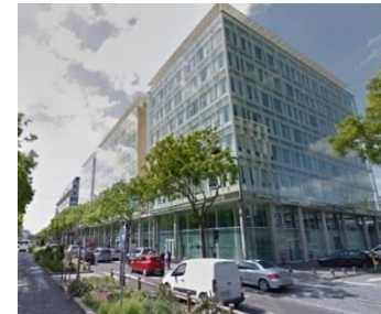
Bâtiment SEL, avenue Thiers (Lyon)
