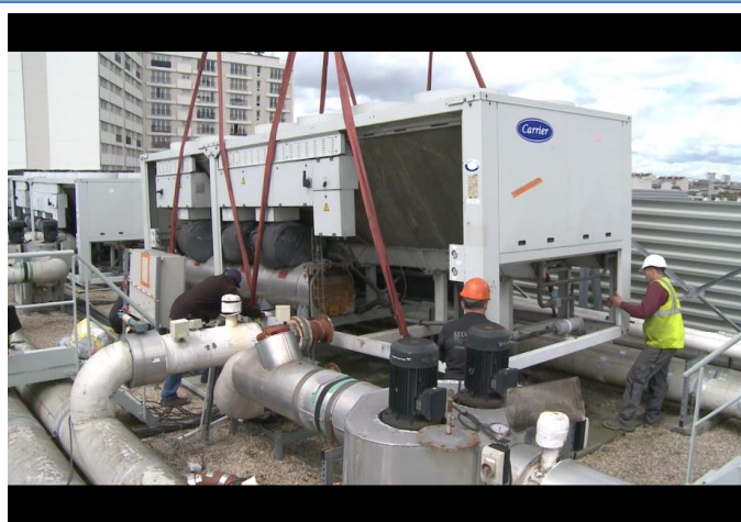
Extrait d'une vidéo d'un candidat : remplacement d'un groupe froid lors du concours
